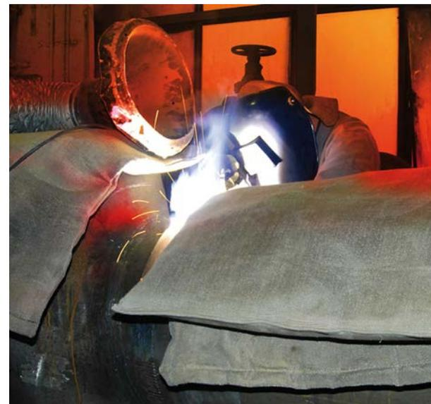
Tappeto imbottito per raffreddamento lento della saldatura, previene gli shock termici e protegge la saldatura dalle impurità. Cuciture rinforzate e tessuto esterno altamente resistente ad abrasione e scorie metalliche.
